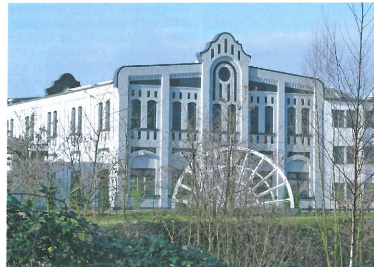
Stinnes-Kesselhaus: Tradition wird gepflegt
